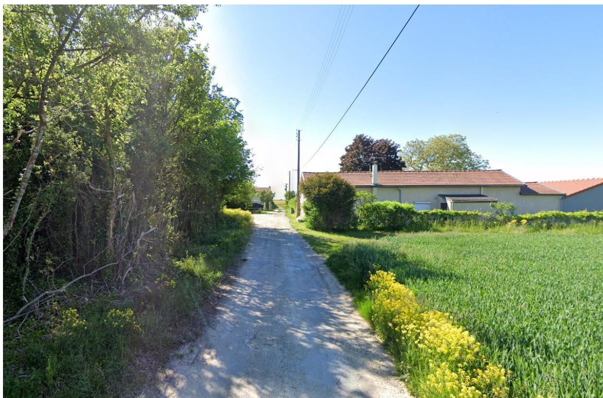
Lignes électriques aériennes existantes au lieu-dit « le Moulin à Vent » (Google Maps, vue de juin 2021)
